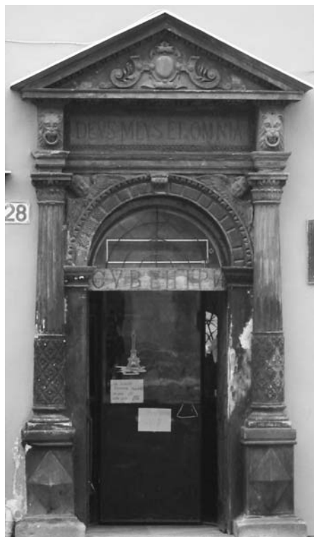
Різьблений портал входу будинку № 28 на Площі Ринок
