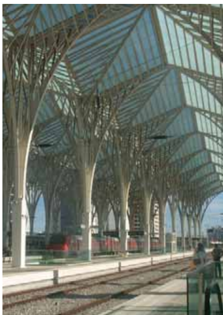
Архітектоніка залізничного вокзалу в Ліссабоні (Португалія)
