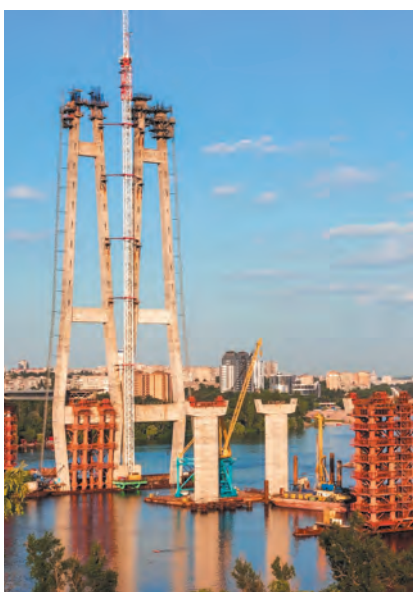
Будівництво моста через Дніпро в Запоріжжі
