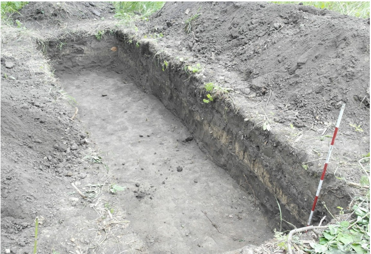
Рис. 13. Мала Клітинка. Рештки тераси та сліди складування будівельних матеріалів та сміття навпроти західної стіни палацу.
