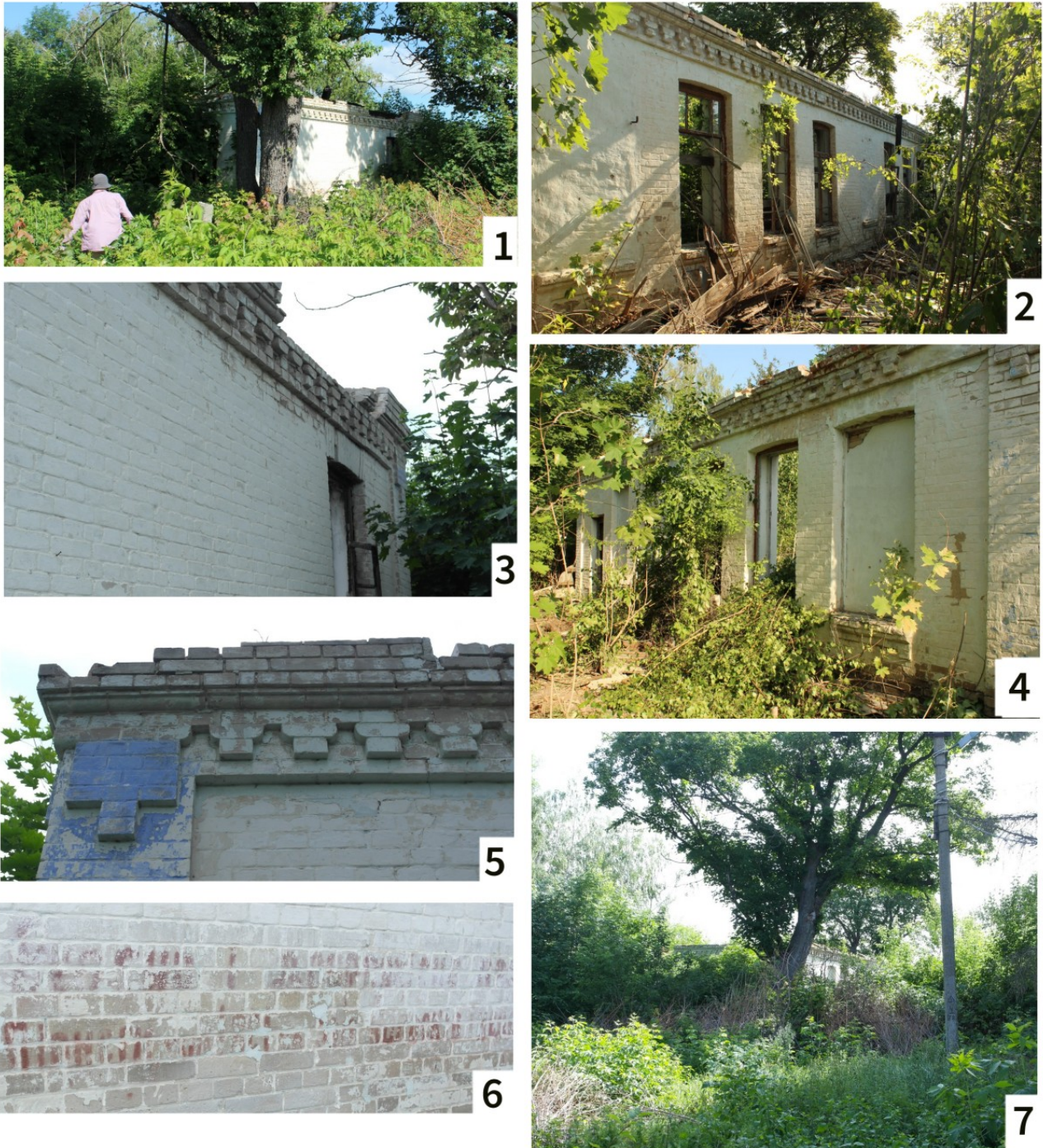
Рис. 29. Мала Клітинка, руїни стайні поруч з палацом. 1.2.4.7- види з півдня та південного сходу. 3,5, - верхня частина стіни з слідами ремонту силікатною цеглою; 6 — сліди напису на східній стіні.
