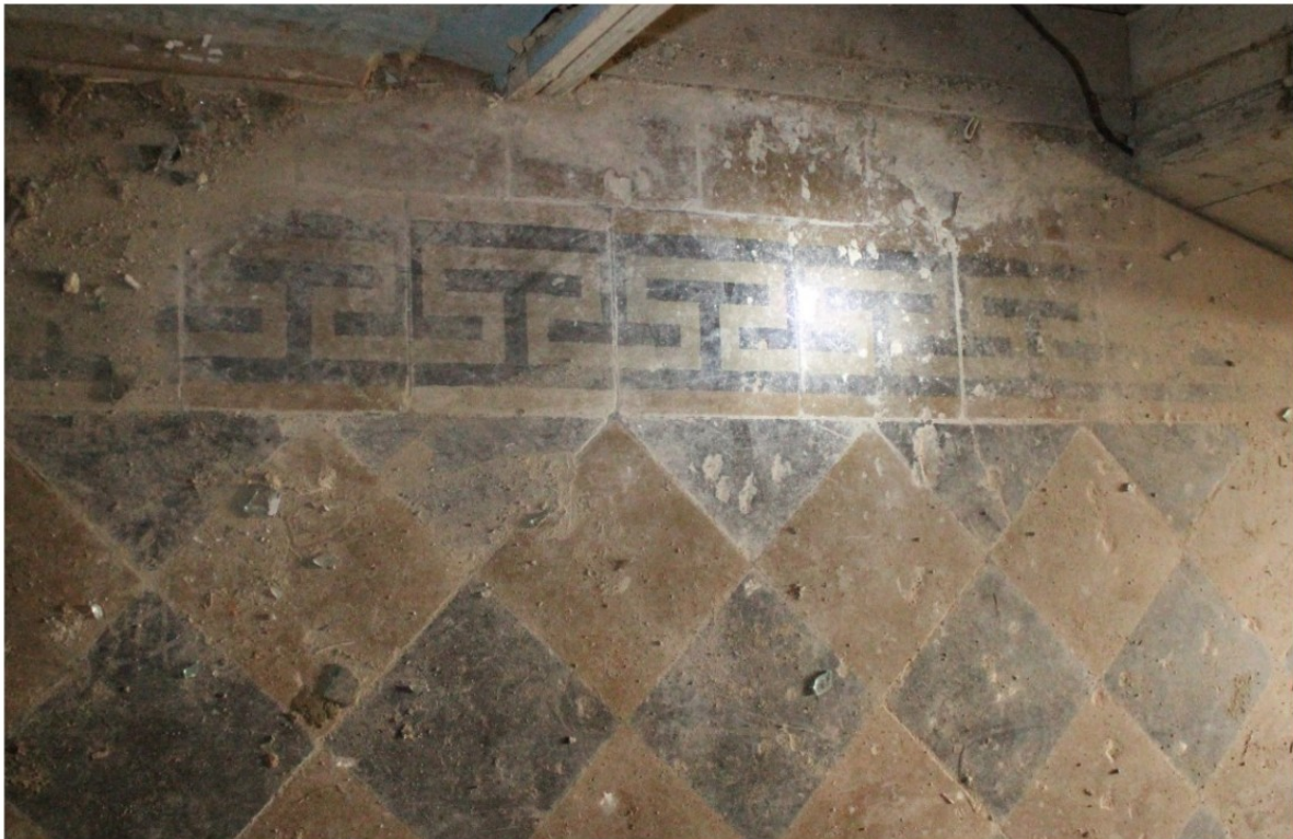
Рис. 20. Мала Клітинка, палац. Кахельна підлога з харківської плитки на першому поверсі прибудови.
